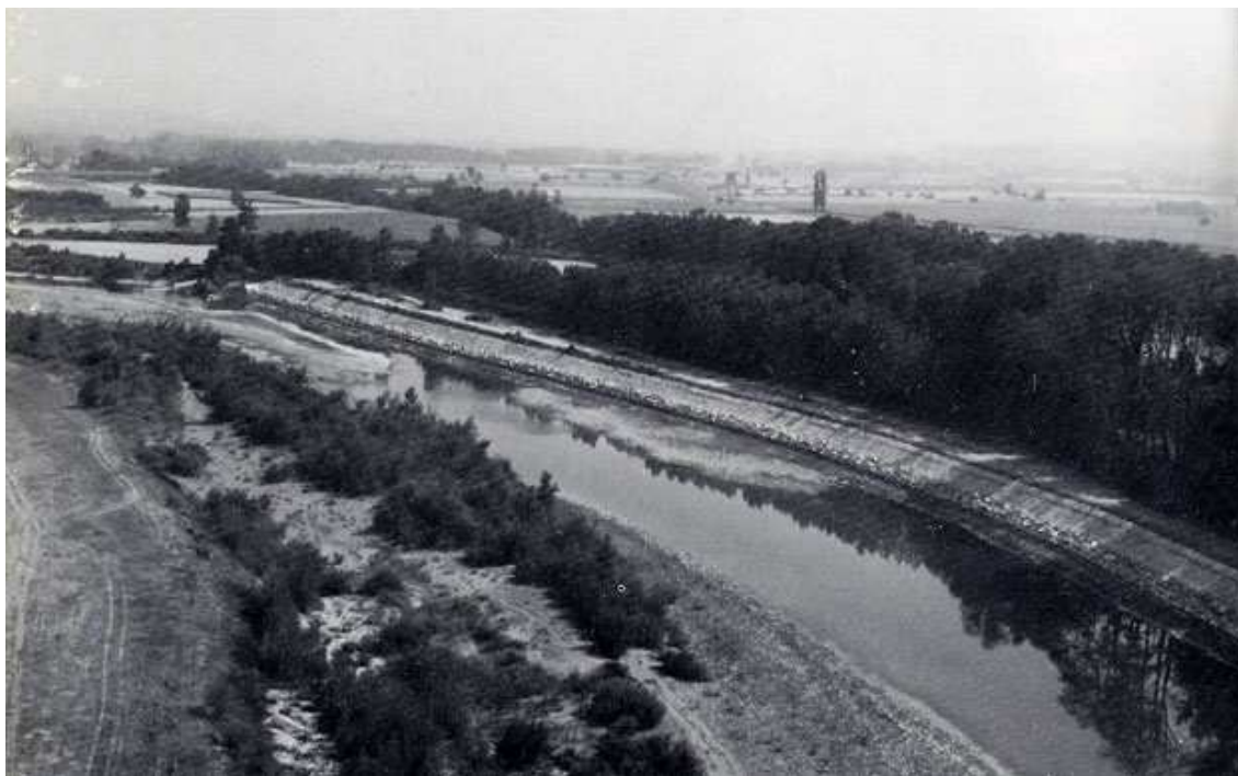
Fig. 43 – Vista aerea dell’inalveamento (fonte: AdBPo).
